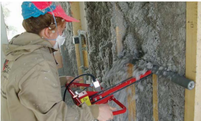
Lissage de la surface avec la brosse à lisser M05
