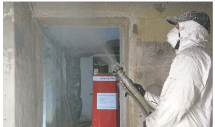
Souvent utilisée pour la pulvérisation humide : la machine mobile X-Floc Minifant
