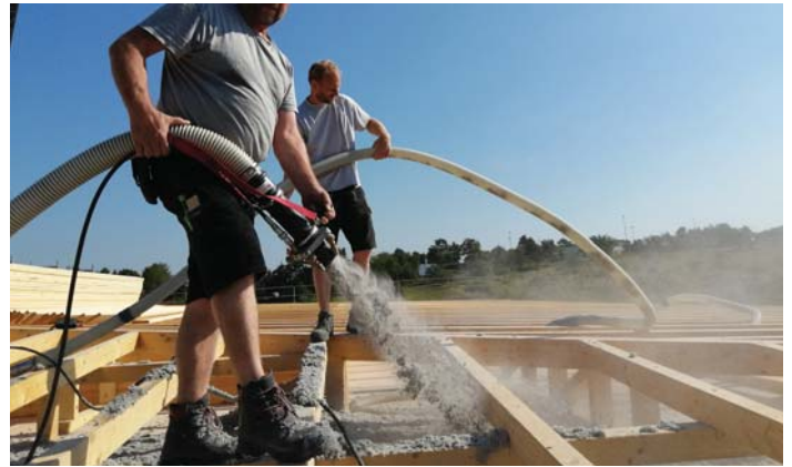
...im Einsatz beim Power-Feuchtsprühen
