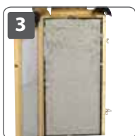
3 Ouverture de l'élément de contrôle pour examiner le résultat du remplissage
