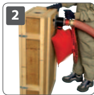
2 Verdichtetes Einblasen mit entlüfteter Drehdüse
