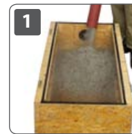
1 Offenes Aufblasen mit Schlauch
