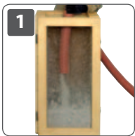
1 Verdichtetes Einblasen mit Schlauch
