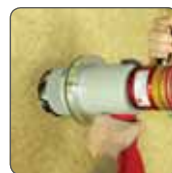
Injecter de matériau
