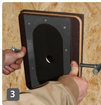
3 Enclencher par contre-pression
