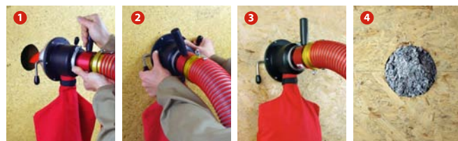
1 Вставьте поворотное сопло с зажимным кольцом 2 Зафиксируйте зажимное кольцо 3 Уложите изоляцию через закрепленное поворотное сопло 4 Задувное отверстие с изоляционным материалом
