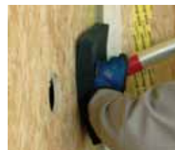
L'aiguille d'insufflation utilisée avec une éponge d'étanchéité
