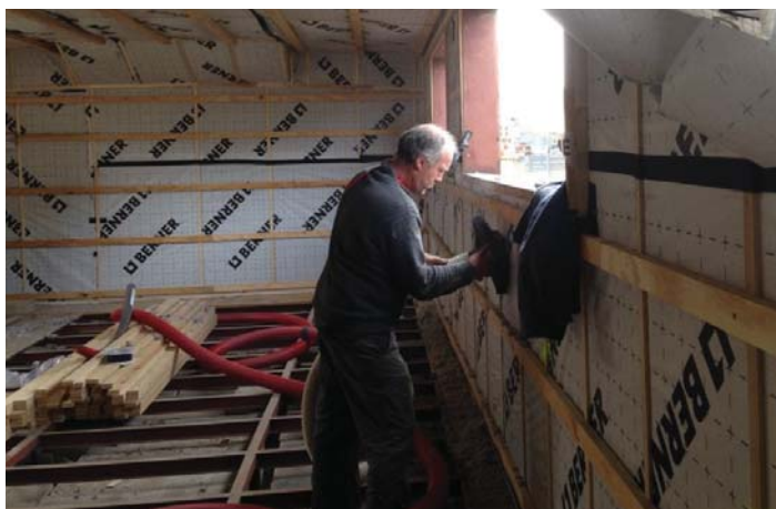
Isolation durable avec de la cellulose
