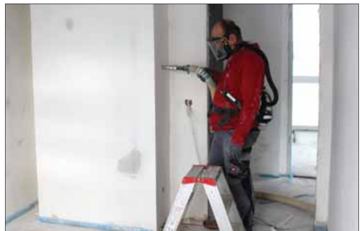
Remplissage des puits
