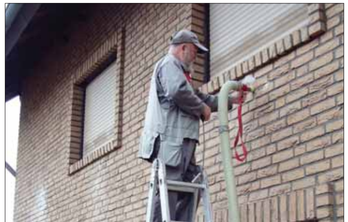
Isolation des murs creux
