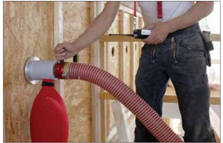
Injection compressée ventilées
