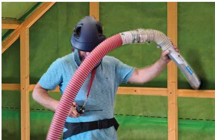
Les raccords tournants pour tuyaux (SDV) facilitent le travail avec l'aiguille d'insufflation
