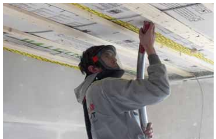
Aiguille d'insufflation avec pointe de tube de forme spéciale et marquée de couleur pour aider à la pénétration
