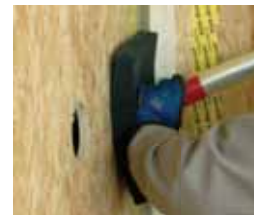
Einblasnadel in der Anwendung mit Abdichtschwamm
