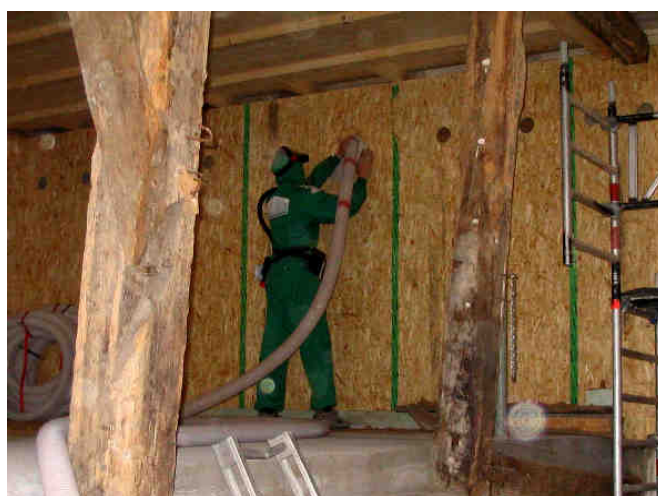
Einblasen mit dem Turbofant M03
