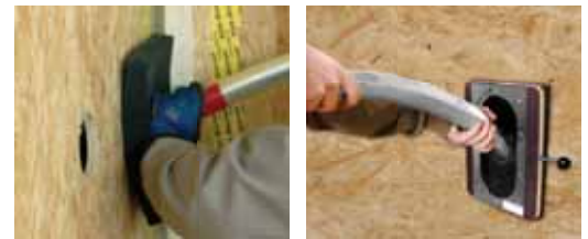
Einblasnadel in der Anwendung mit Abdichtschwamm
